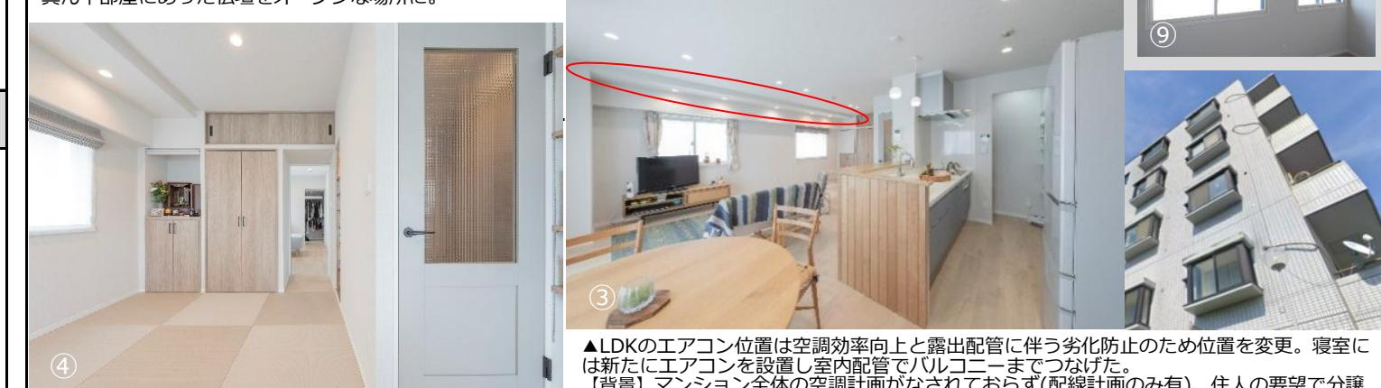
▲LDKのエアコン位置は空調効率向上と露出配管に伴う劣化防止のため位置を変更。寝室には新たにエアコンを設置し室内配管でバルコニーまでつなげた。
