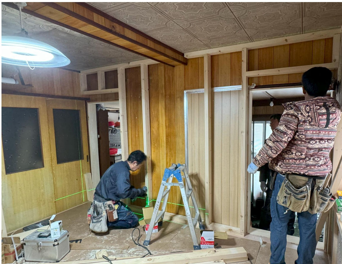
壁の下地材を施工
