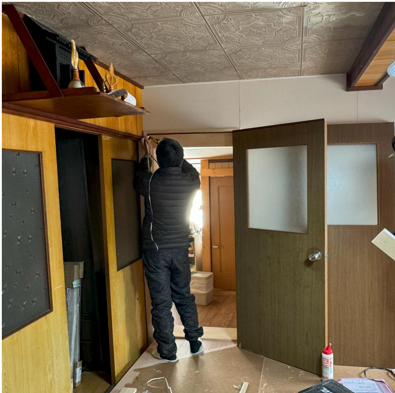
隙間風防止にピンチブロックの取付け
