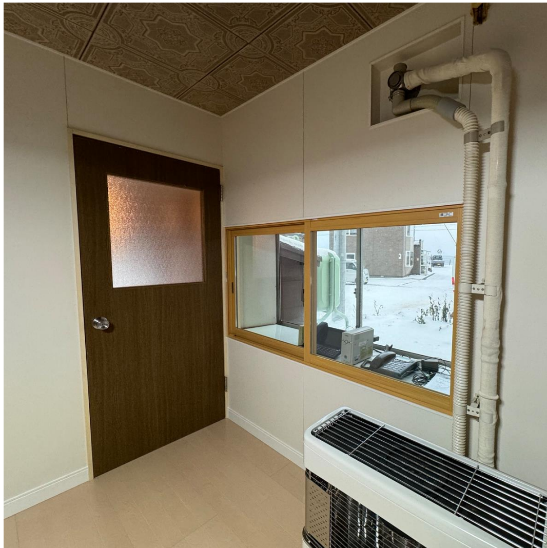
内装ドアの取付（復旧）
