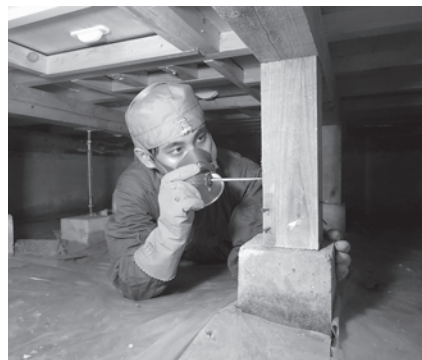
シロアリ床下点検の様子
